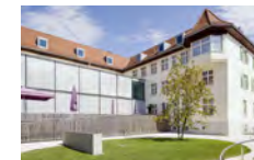
Umbau Sozialzentrum Schützengarten
