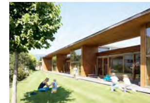
Neubau Kindergarten Rosenlacherstraße
