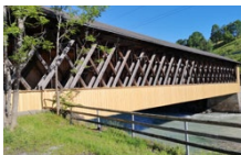
Sanierung Holzbrücke über den Fluss Ill (Gemeinschaftsprojekt Göfis und Frastanz)
